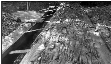
Obnova jezu v roce 2011.
